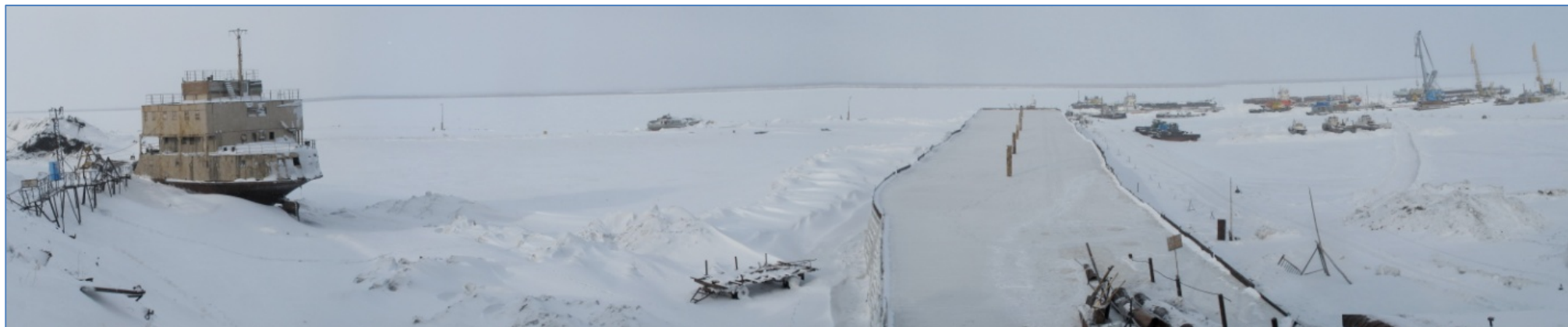
Фото 7. В порту Хатанги. Ледяная дамба для защиты акватории во время весеннего паводка.
