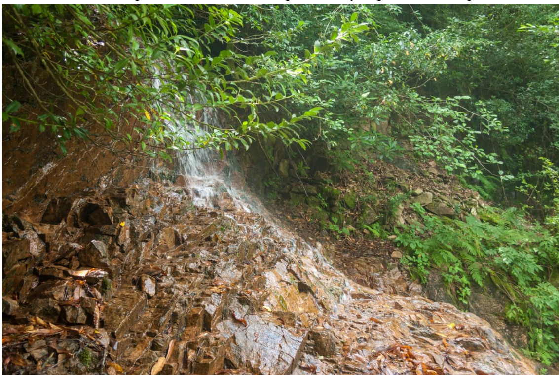
Фото 1.3. Наклонный прижим (после прохождения).
