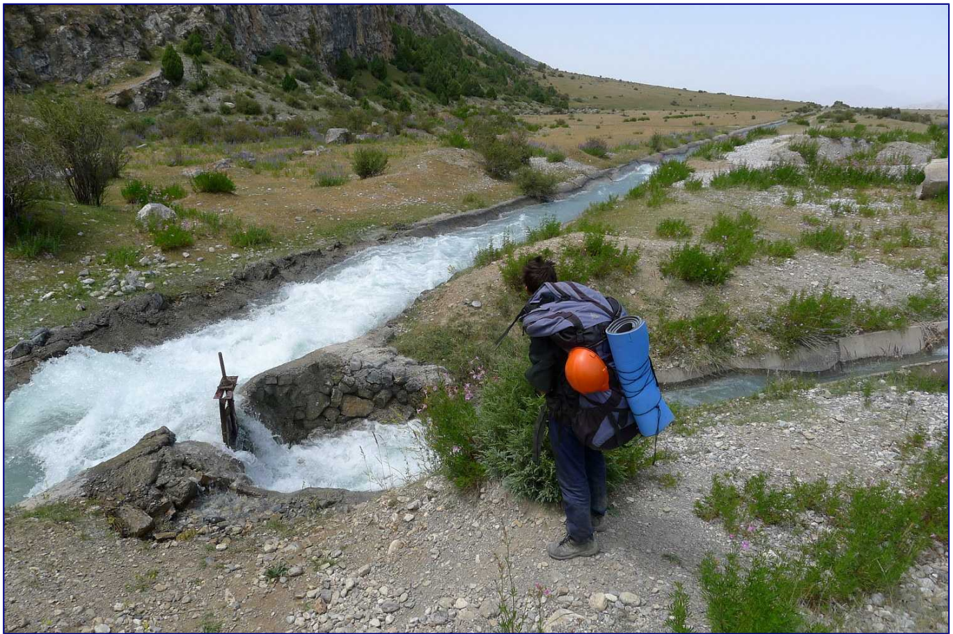
Ф.114. Поток воды в ответвлении от арыка Гавиан контролируется заслонкой.
