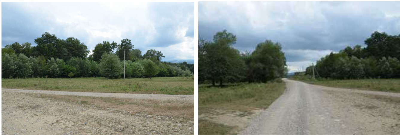
Рисунок 5.8 – ЛЭП 10 кВт ОАО "Кубаньэнерго"
