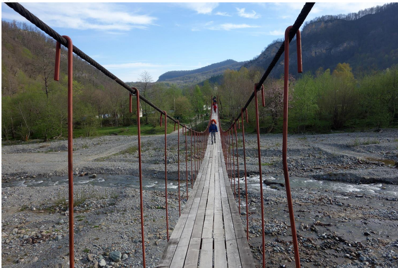
Ф.1. Подвесной мост через р. Никитинка.
