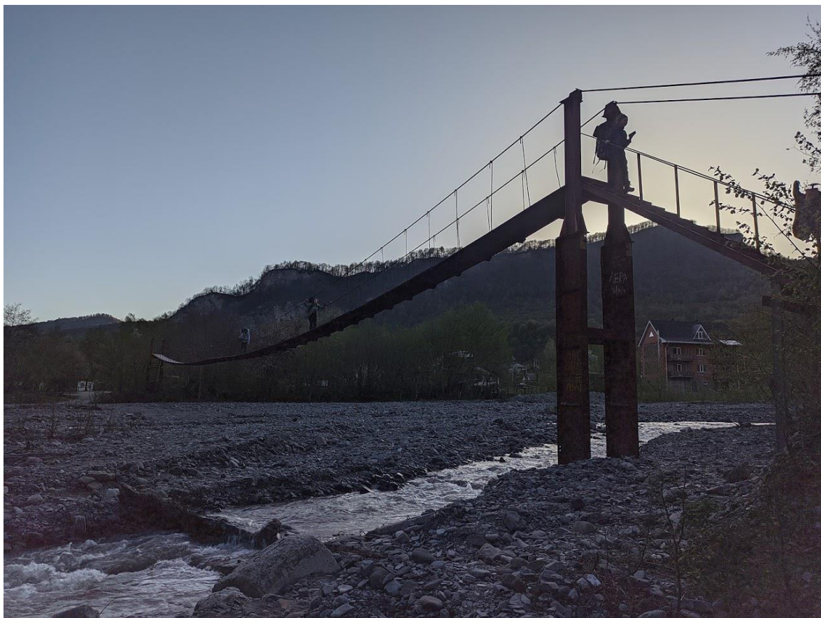
Ф.1. Подвесной мост через р. Никитинка.
