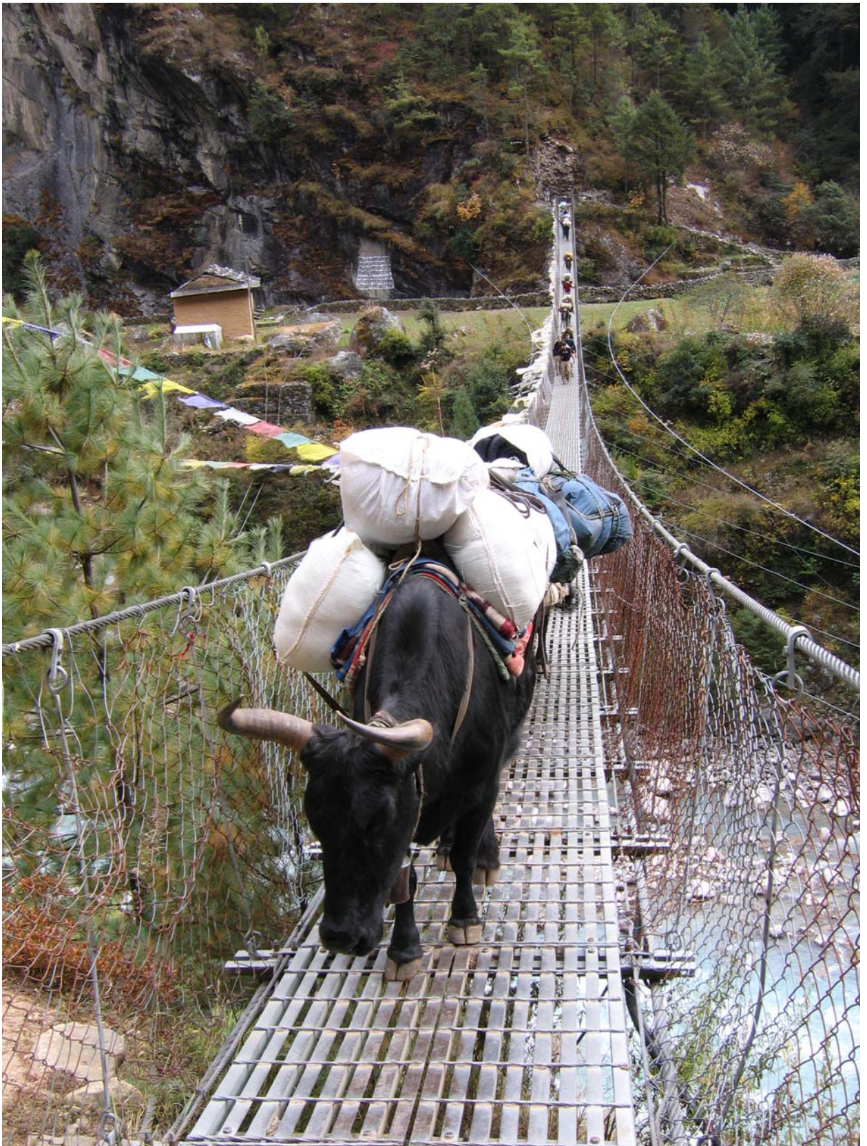
Фото 43. Один из мостов через реку Дудх Коши
