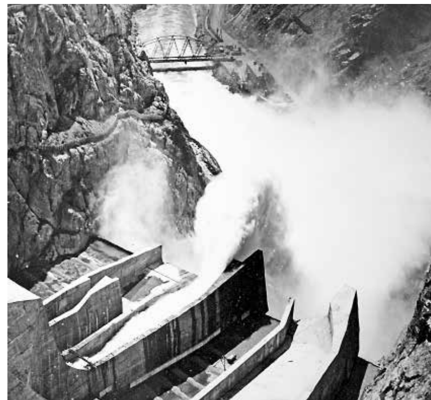
Вид работы носков водосброса
