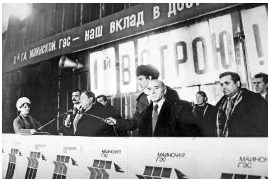
Пуск 1-го агрегата МГЭС, 1984 г.
