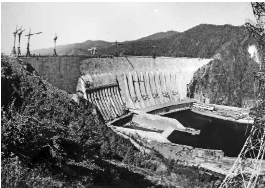
Общий вид Гидроэнергетического комплекса Саяно-Шушенская ГЭС – 10 агрегатов. Напорный фронт 1066 м. Высота плотины 245 м
