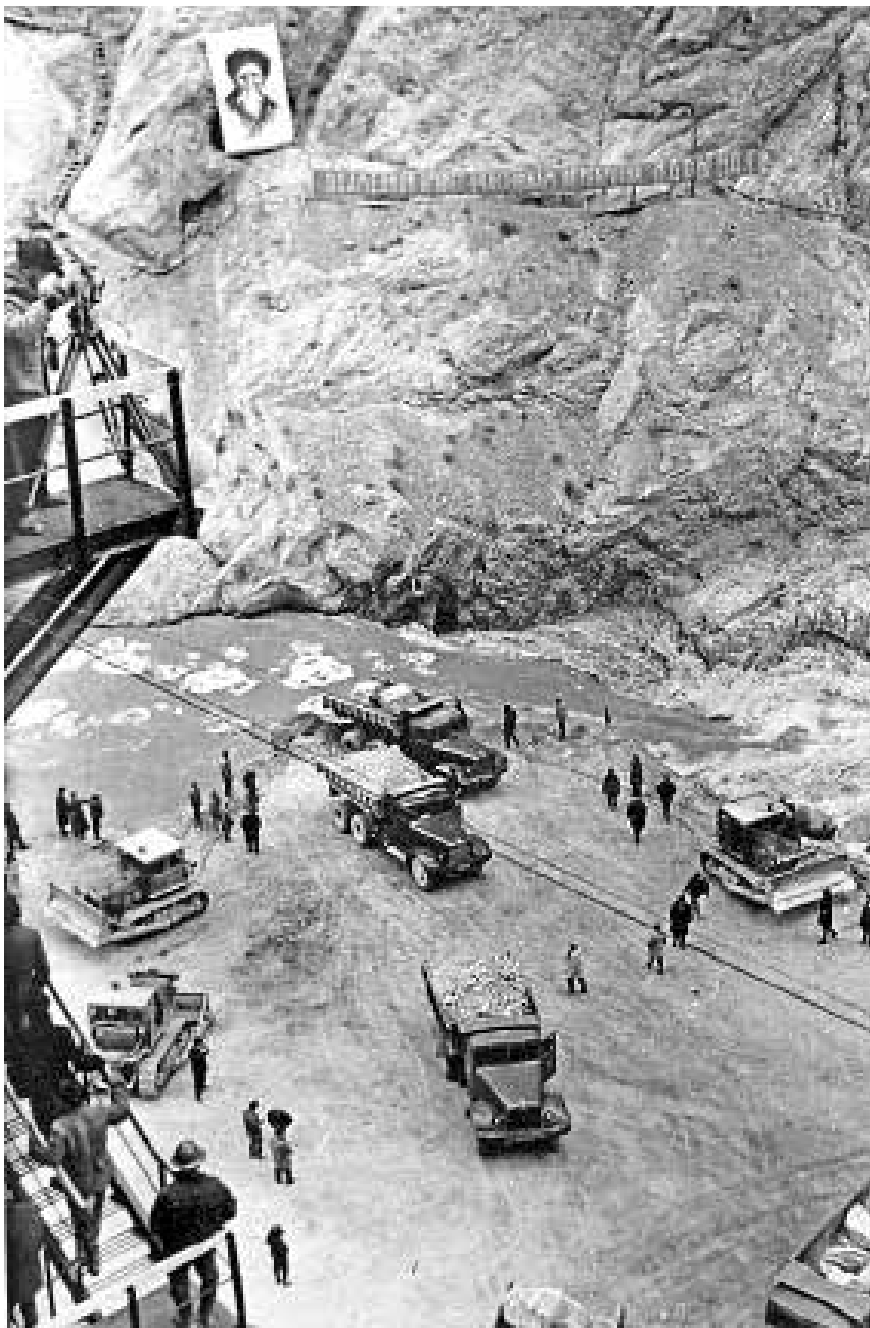
6 января 1966 г. Перекрытие р. Нарына, на скале портрет Токтогула
