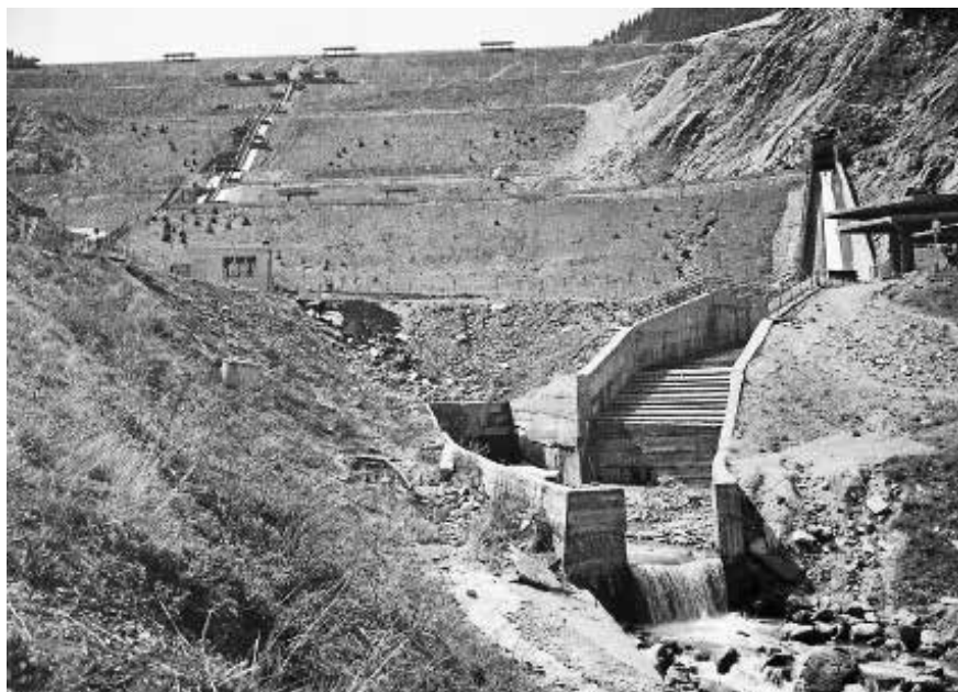
Общий вид плотины Медео
