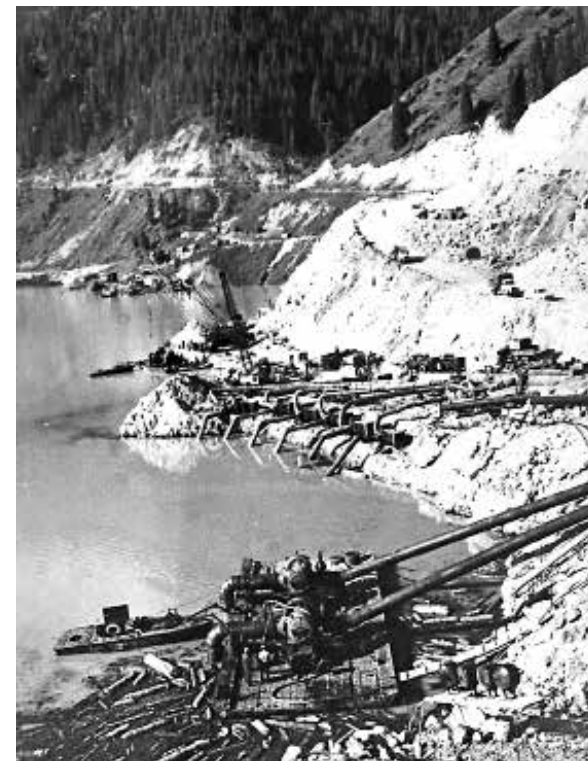
Насосы в верхнем бьефе плотины для перекачки прибывающей воды через плотину
