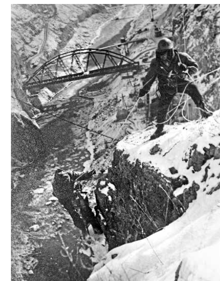
Устройство камнезащитных ловушек
