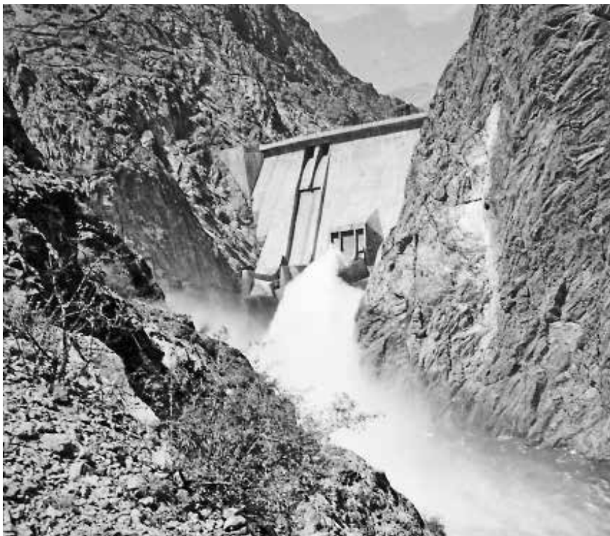
Сброс воды через водосбросы
