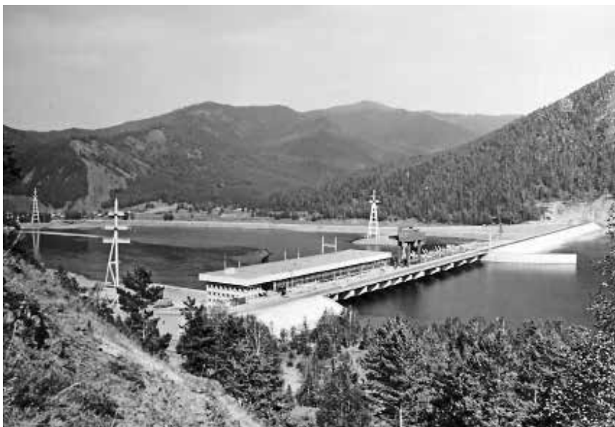
Майнская ГЭС. 3 агрегата. Напорный фронт 132,5 м. Высота плотины 32 м
