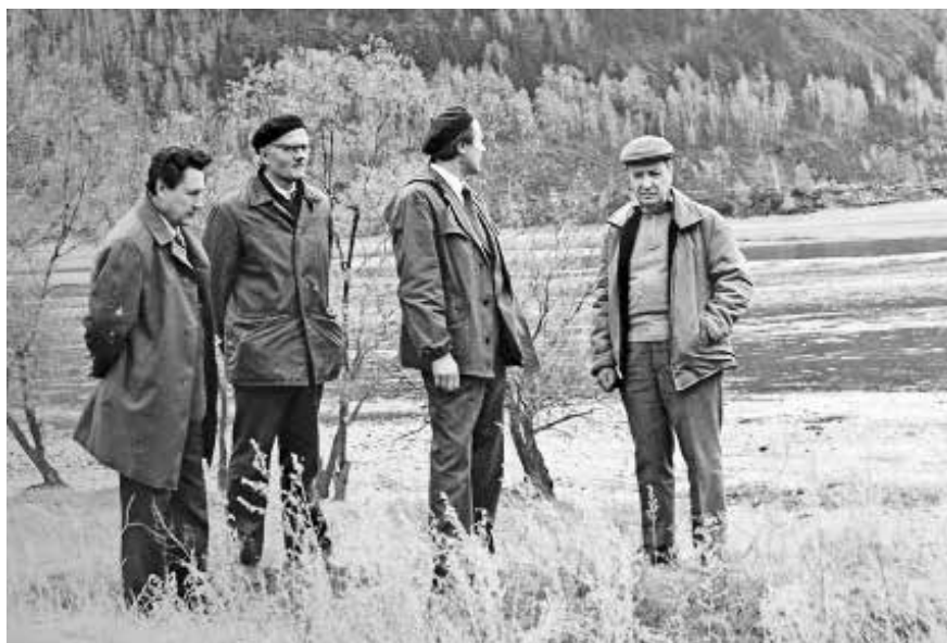
Выбор створа Майнской ГЭС
