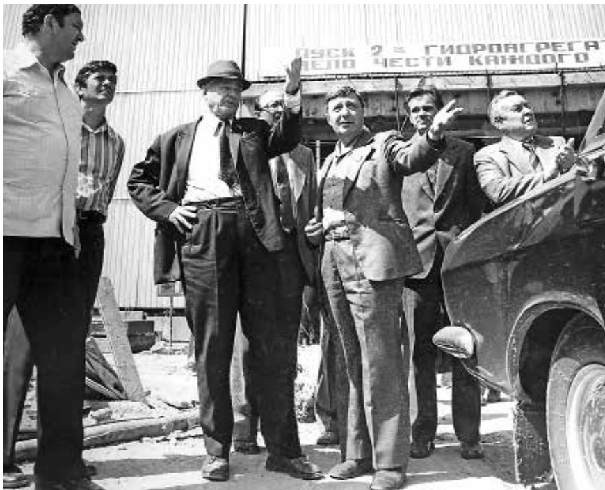
Гл. инженер К.К. Кузьмин объясняет обстановку на строительстве
