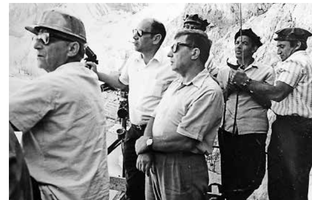
Руководство наблюдает. Гл. инженер проекта Кузмин К.К., гл. инженер строительства Толкачев, зам. гл. инженера Шангин В.С.
