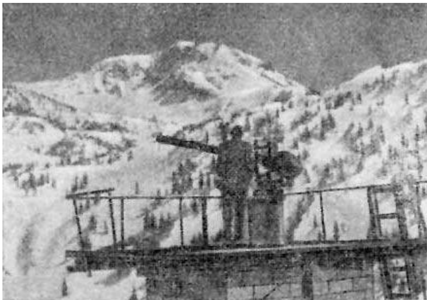
Безоткатное орудие, примененное позднее в Алте для борьбы с лавинами, на позиции с круговым обстрелом.
