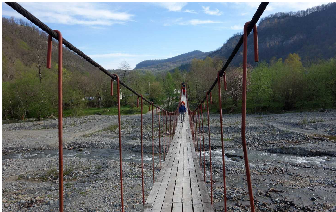
Фото 2. Подвесной мост через р. Никитинка. Фото 2019г. [1]
