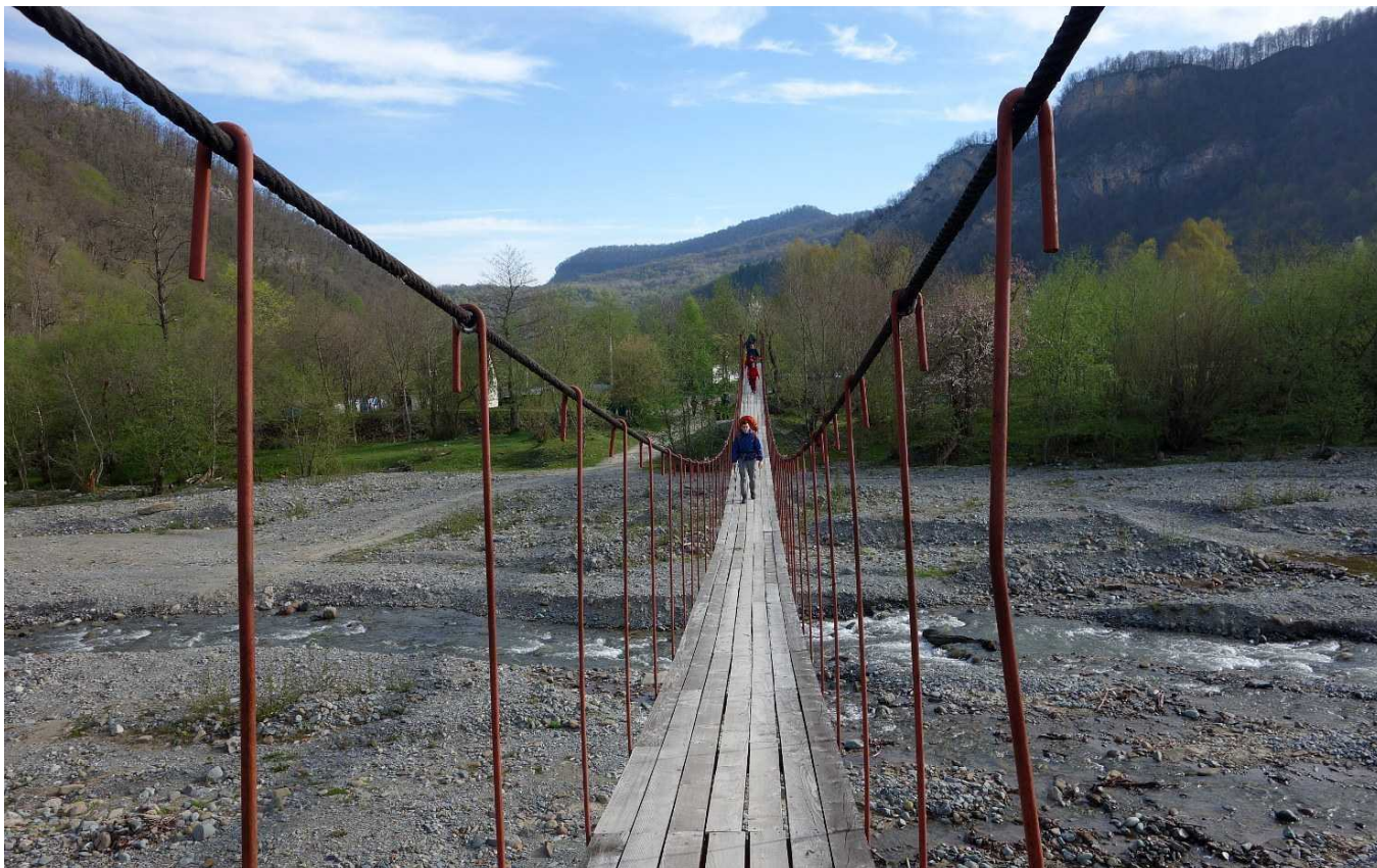
Фото 1. Подвесной мост через р. Никитинка. Фото 2019 г. [1]
