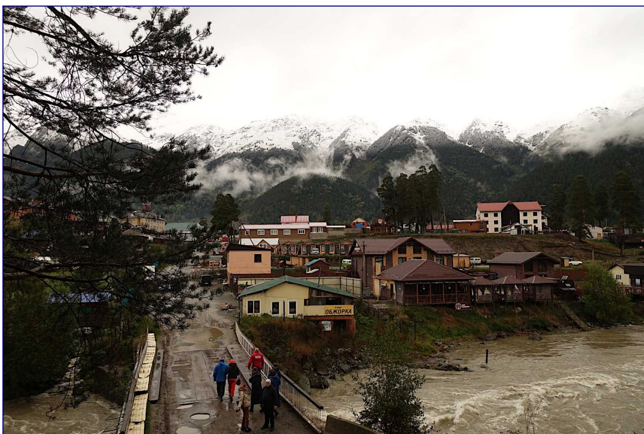
Ф. 32. Мост через Большой Зеленчук в поселке Архыз.
