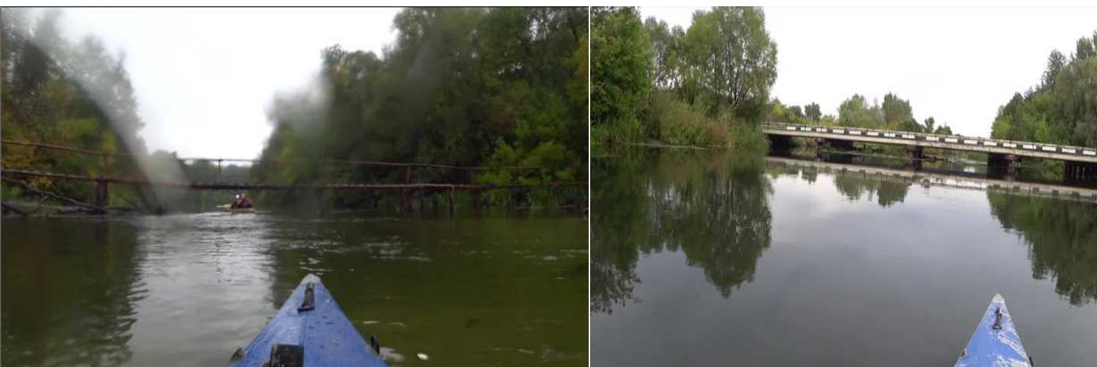
Фото 29,30. Мосты: пешеходный в 10:33 и на село Перевоз в 15:58
