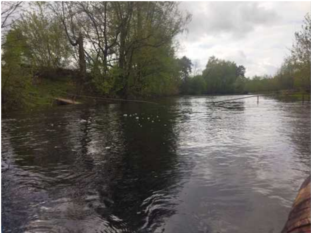
Фото 2. Разрушенный пешеходный мост.
