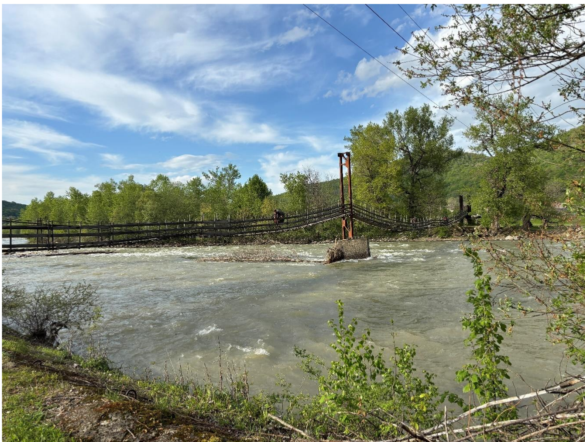
Ф91. Реку Большая Лаба мы пересекли по мосту в пос. Бескес.
