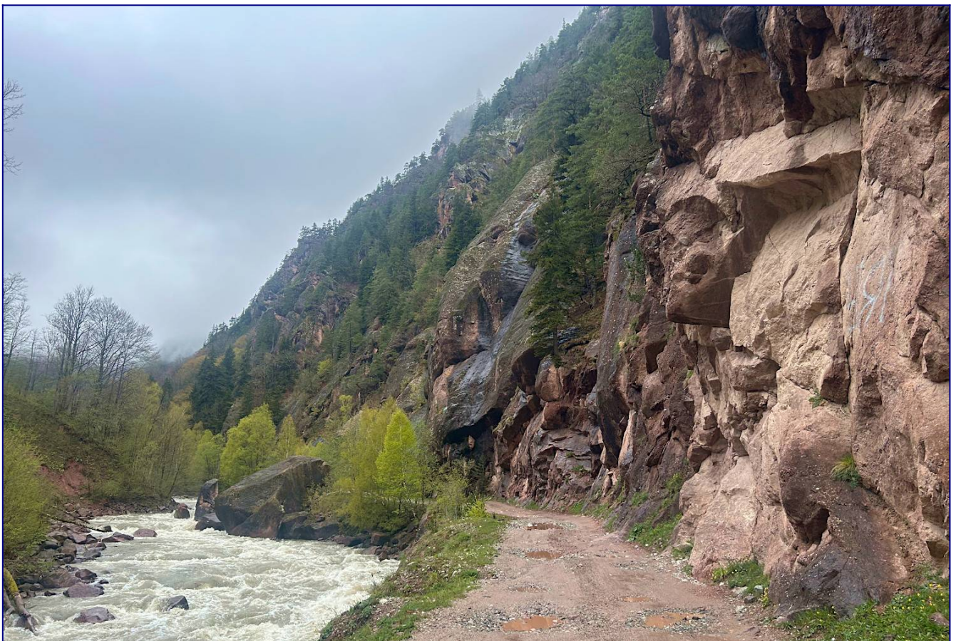
Ф.18. Участок дороги вдоль Большой Лабы в 2-х километрах ниже Верхнего Соленовского моста.
