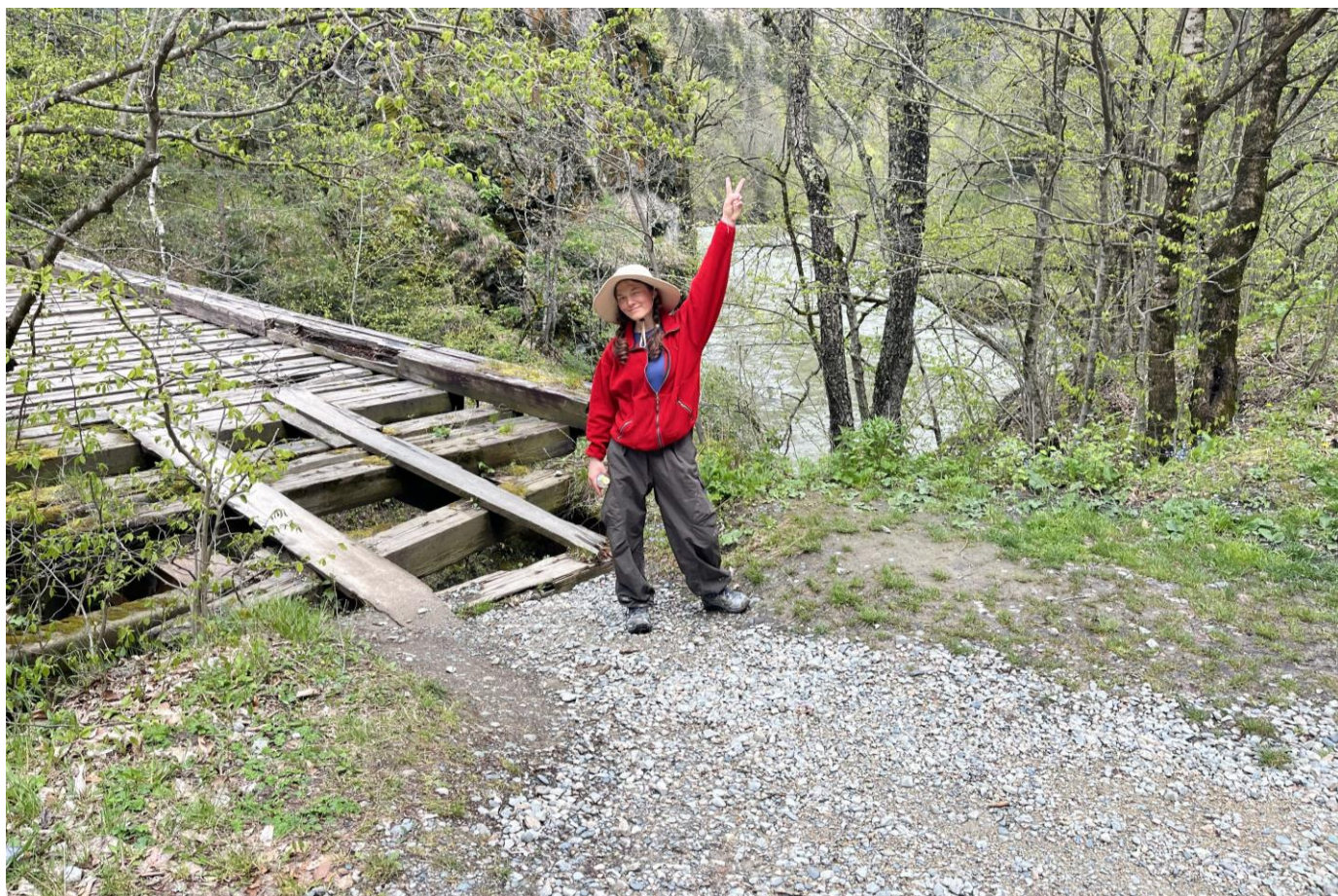
Ф.58. Мост через реку Большая Лаба, ведущий к заброшенным Штольням
