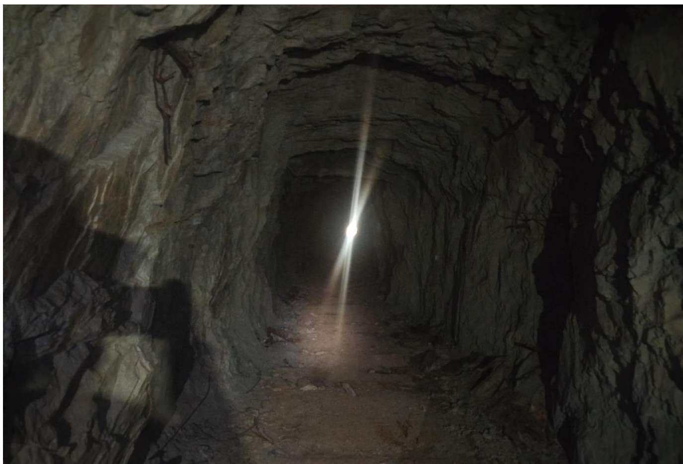
Ф.59. Внутри заброшенных штолен
